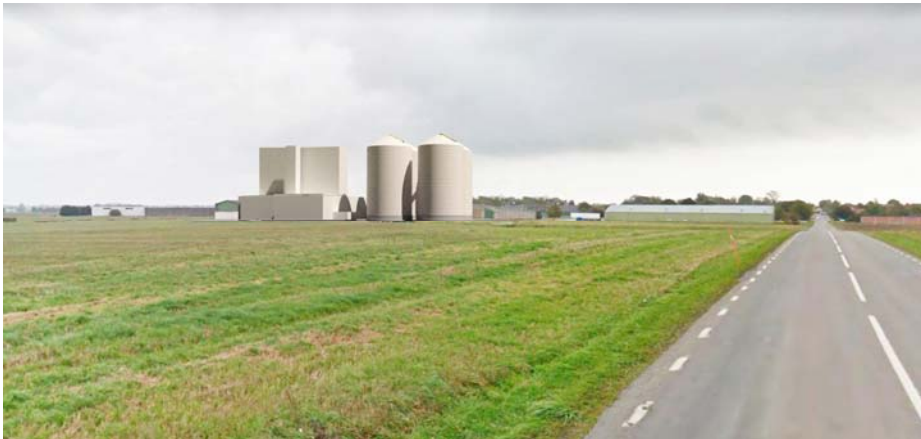
Nya silobyggnader och befintlig hög byggnadsdel sedda från Smedstorpsvägen.
