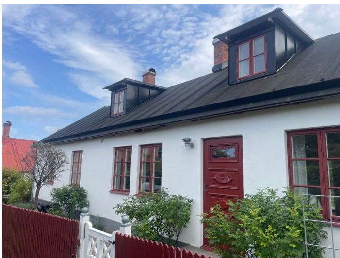
Ljus puts, mörk kulör och takkupor
