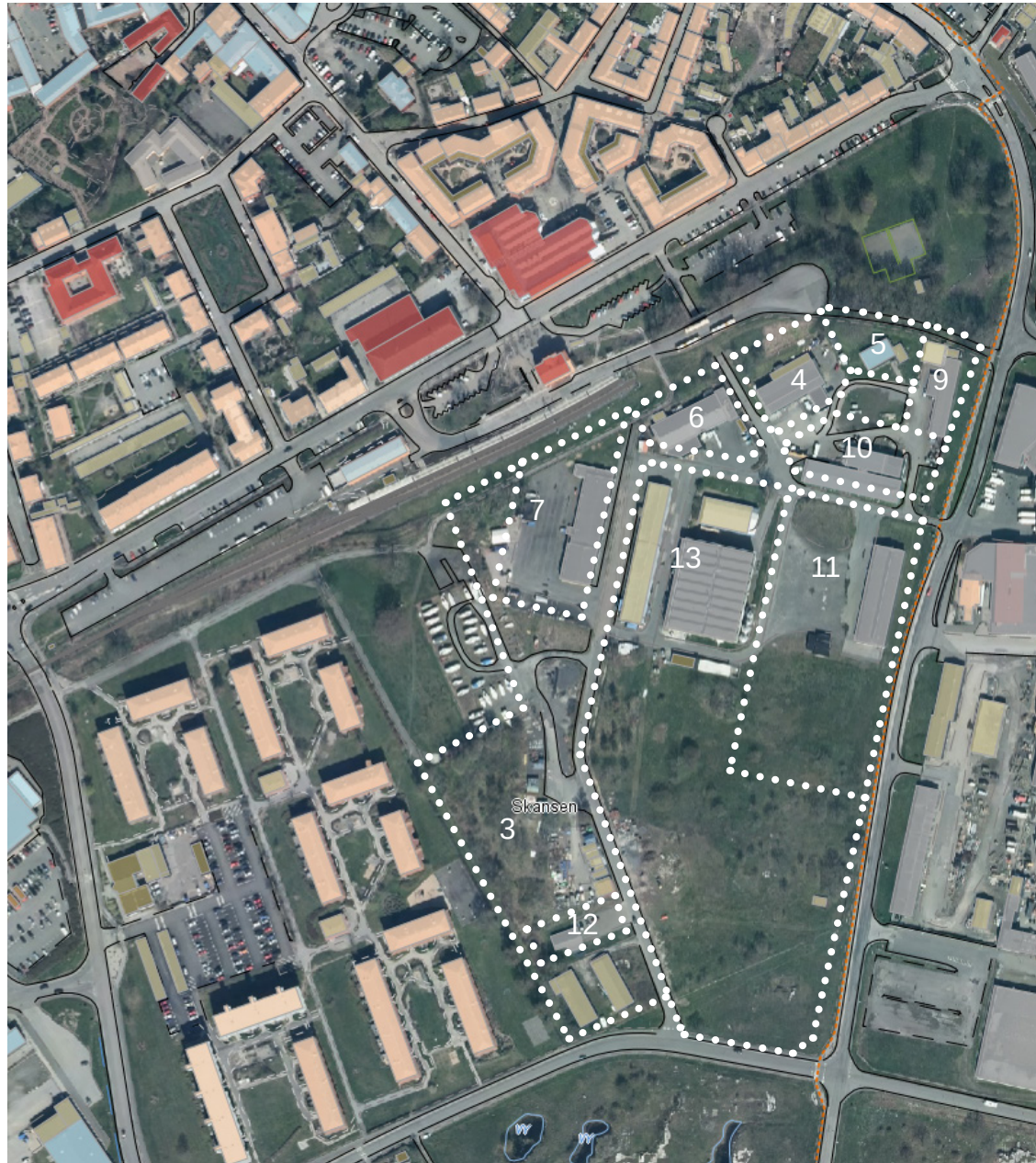
Fastigheter inom programområdet som har befintlig bebyggelse.
