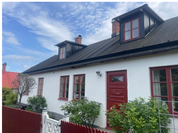
Ljus puts, mörk kulör och takkupor
