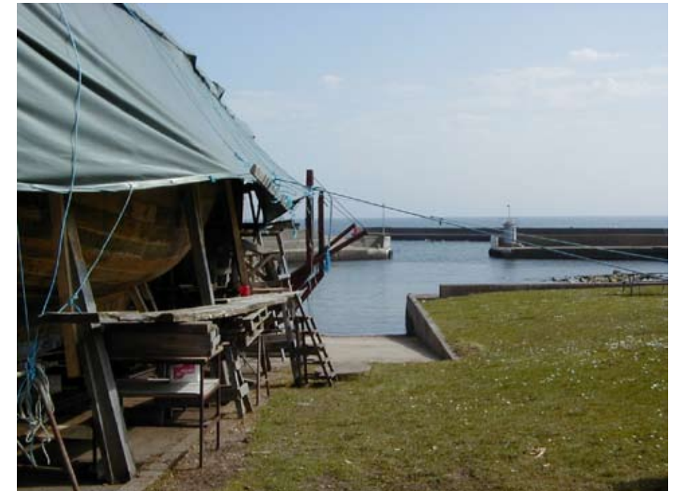
När segelskutan Hoppet byggdes i Brantevik sågades till och med brädorna till bordläggning och däck, på plats. Det finns en gedigen kunskap om skeppsbyggnad i byn.
