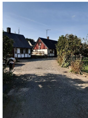
Bild: Ola Cappelins väg från syd. Hjälmaröd 4:98 (1) till vänster, Hjälmaröd 4:98 (2) till höger.
