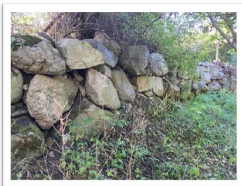
Mot sydväst, stenmur på grannfastighet Mellby 25:76 i södra delen.
