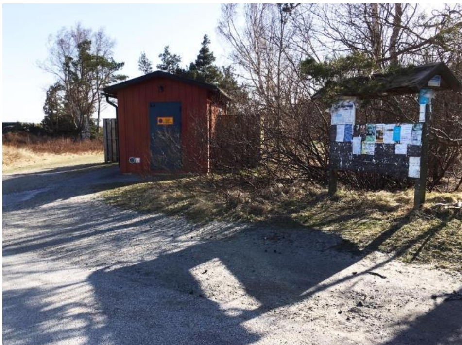
Vid Mälarhusvägens slut ligger en toalettbyggnad
