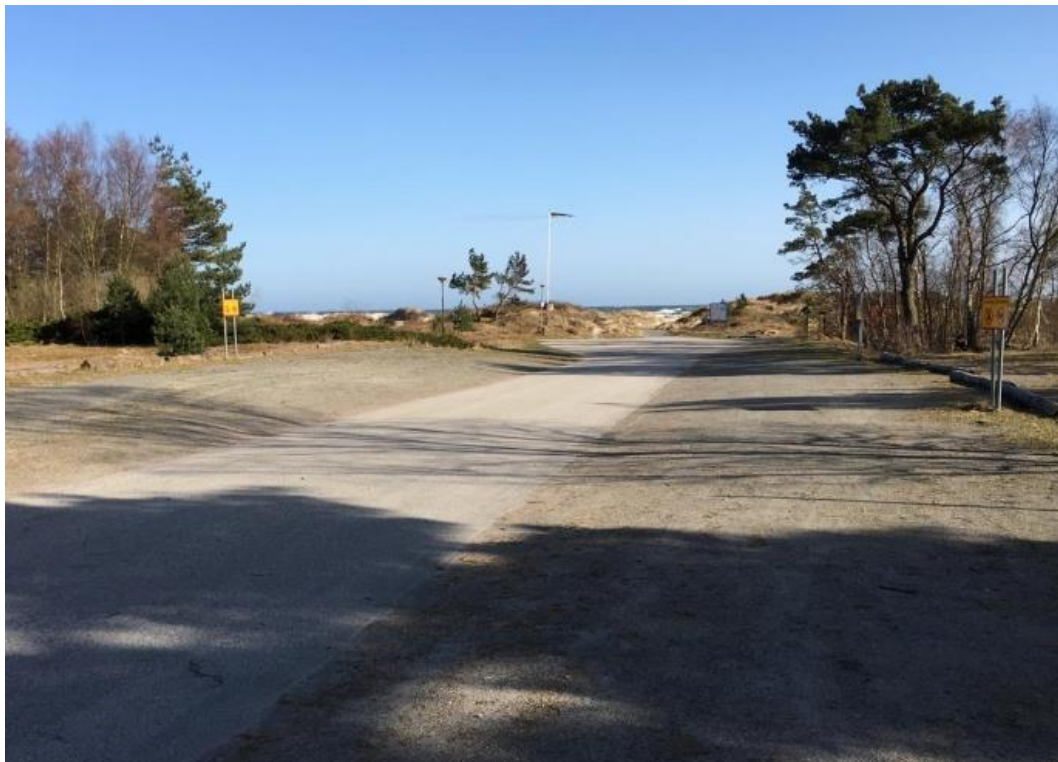
Längs Mälarhusvägen mot havet. De grusade partierna på ömse sidor om vägen fungerar som parkeringsytor sommartid. Den gamla restaurangbyggnaden låg i bildens vänstra kant
