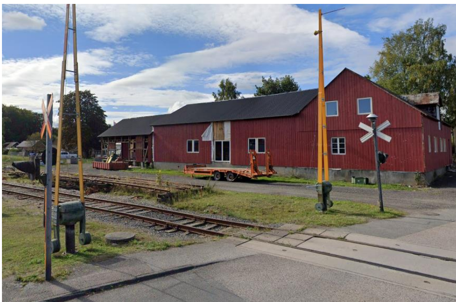
Bild över byggnaden inom planområdet.
