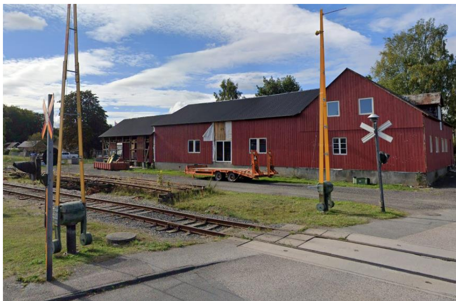
Bild över befintlig byggnad inom planområdet.
