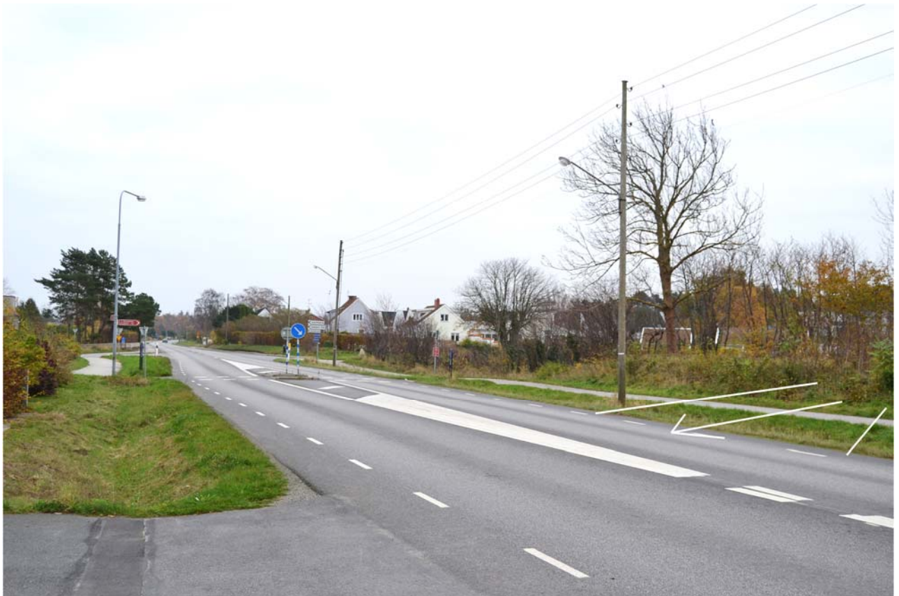
Vy i riktning mot Simrishamn längs väg 9. Läge för planerad ny utfart från Viks fiskeläge 1:32 markerad med pil. Den nya utfarten gör att korsningen för gång och cykel behöver byggas om. Ett vänstersvängkörfält bör anläggas för trafik från Simrishamn.
