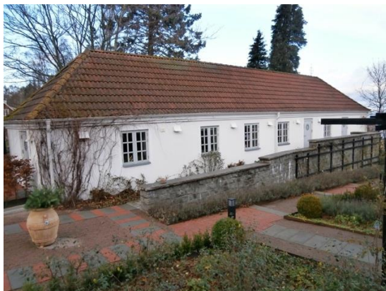
Villa Julia, f d fruktpackeri. Byggnadens volym ska värnas. Fasaderna ska vara putsade.
