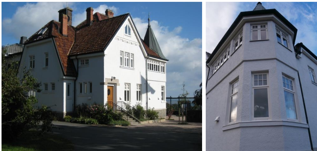
T.v. Villa Emiliero. Byggnadens volym får inte ändras. Byggnadens karaktärsdrag ska värnas. T.h. Fasadputsen och fönsterindelningen på Villa Emiliero ska värnas.
