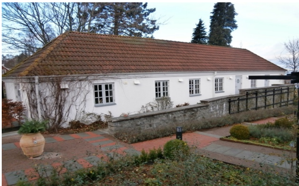
Villa Julia, före detta fruktpackeri. Byggnadens volym ska värnas. Fasaderna ska vara putsade.
