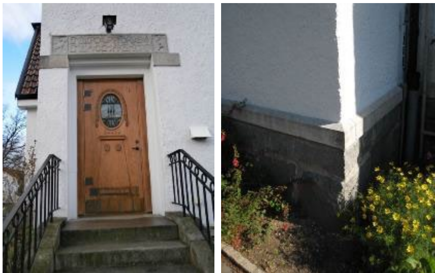
T.v. Entrépartiet på Villa Emiliero ska värnas. T.h. Sockelmuren på Villa Emiliero ska värnas.
