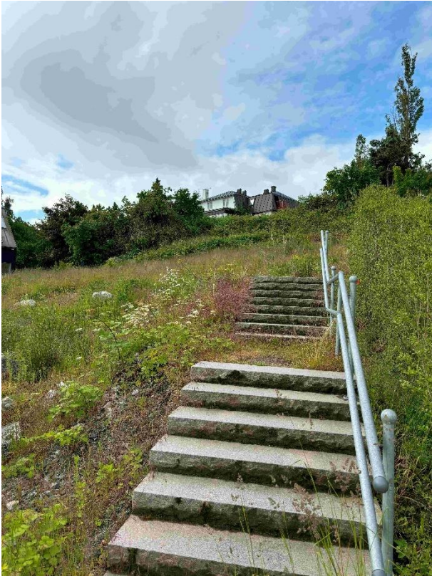
Figur 5 Bild över slänten inom fastigheten 4:250. Trappan ligger inom en annan fastighet (Norconsult 2024-06-17).
