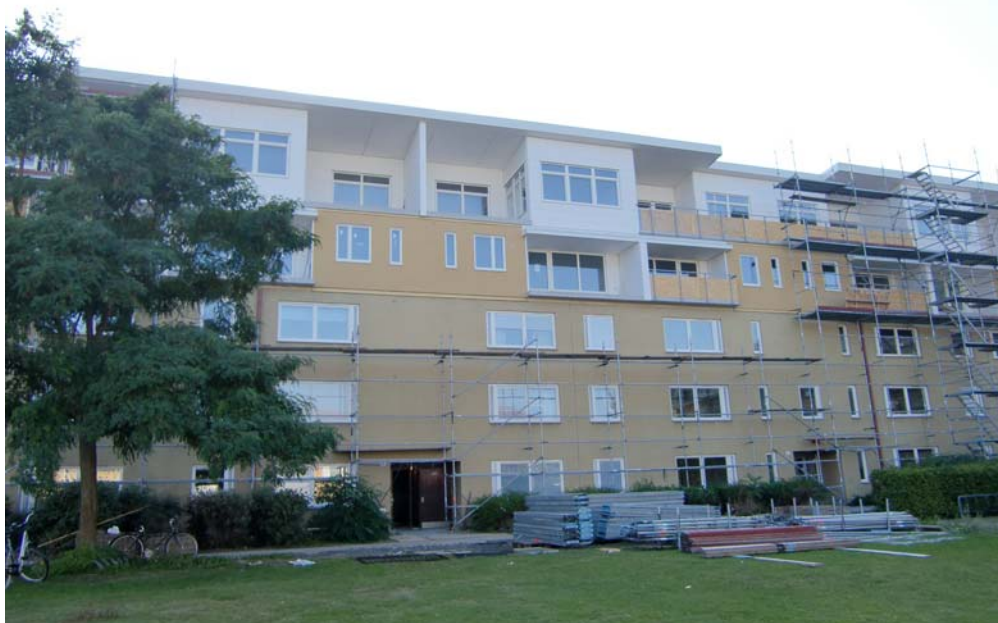
Det nya trapphuset på Brukskatan är under uppbyggnad. Foto: Birgitta Malm
