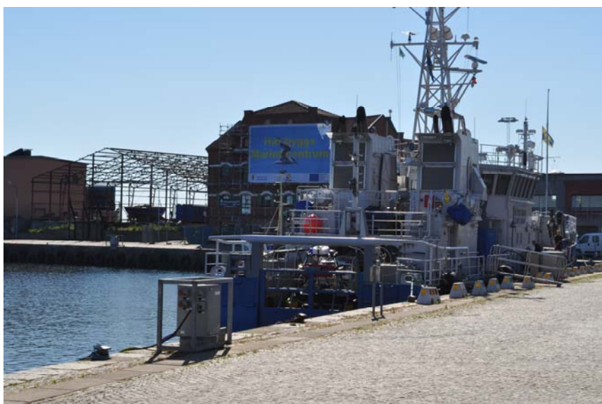
Här byggs Marint Centrum. Foto: Madeleine Lundin
