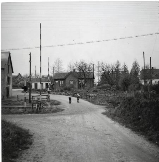
Järnvägsövergång i Vitaby på sträckan mellan Brösarp och S:t Olof, 1957. Foto: Jvm.KDBB00874, Trafikverket.
