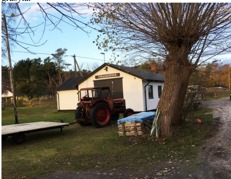
Befintlig byggnad. I tomtgränsen mot söder och den samfälliga vägen står en pil.
