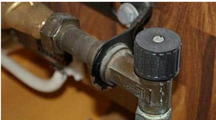
Figur 1: Byt avstängningsventiler om du har denna typ, LK580.
